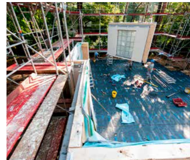
...und das Erdgeschoss auf das Fundament montiert.
