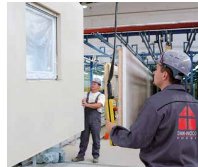
Die Wände werden in der Fabrik vorgefertigt...
