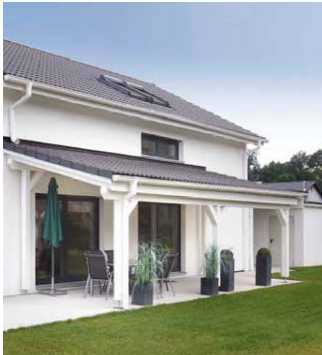
Solides Dach über der Terrasse
