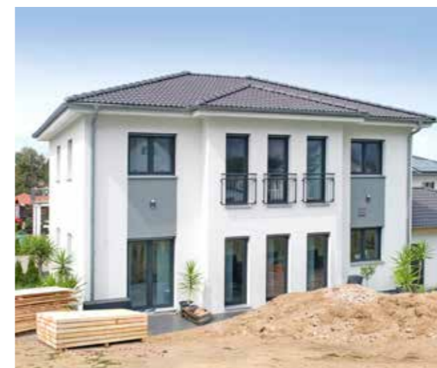
Nach ca. 12 Wochen ist die Villa fertig...
